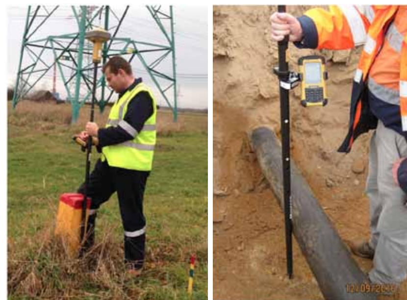
图10-11：左：使用 UNISCAN™ GNSS 系统对管线路线上方地形特征的位置进行电子记录。右：SCT™ 的 GNSS 定点功能用于在挖掘期间返回现场时定位预测的内部腐蚀位置。
